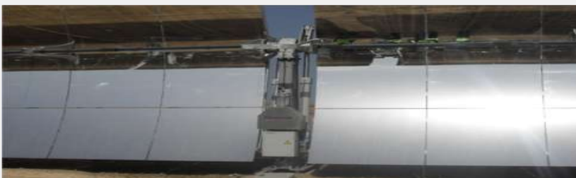
Fig. 7 Sistema hidráulico FLUITECNİK HAWE totalmente montado
